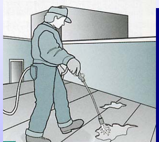
Vyspravenie lokálnych nerovností starej hydroizolácie.
